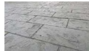
スタンプコンクリート舗装1
